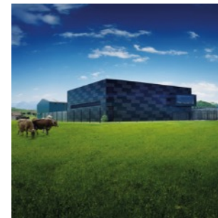
Rechenzentrum SAK Gais (CH)
