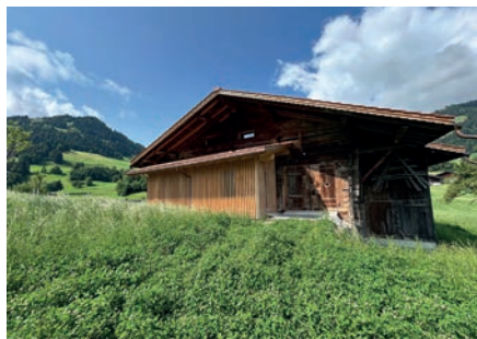
Rückwärtiger Anbau (Eingang)
