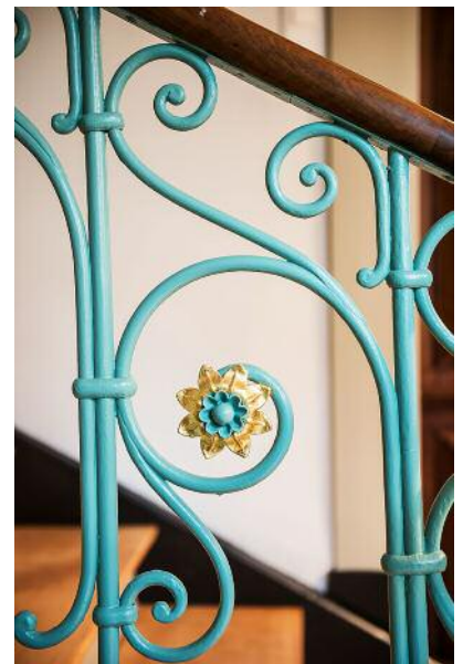
Spuren von Blattgold an den Blumenornamenten des Geländers wiesen auf eine zweifarbige Fassung hin, die wieder instandgesetzt wurde.
