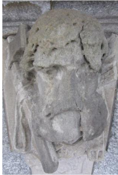
Von der Witterung stark zerfressener Sandsteinkopf des Sternzeichens «Schütze», so wie er sich vor der Restaurierung präsentierte.
