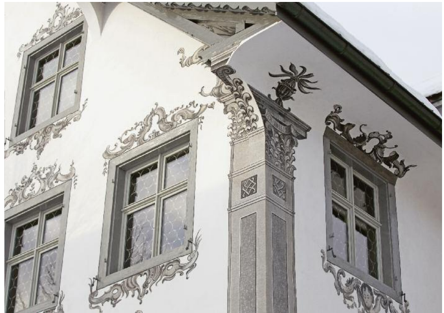
Die gemalten Eckpilaster mit aufgesetzten Vasen veranschaulichen besonders schön, wie die Bemalung den Fachwerkbau in einen Steinpalast verwandelt.
