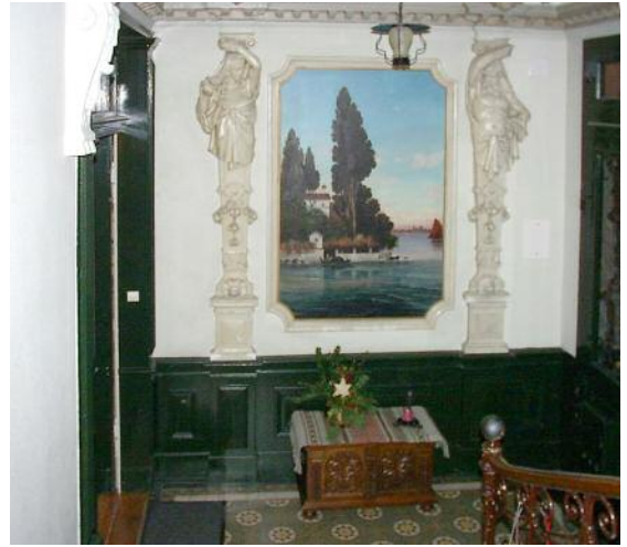
Vor der Restaurierung präsentierte sich das Entrée mit grün gestrichenen Holzarbeiten, braunem Geländer und monochrom gefassten Wänden und Decken.
