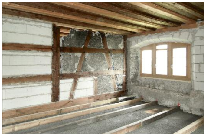
Derselbe Raum während der Renovation mit ergänzter Bohlen-Balken-Decke und aufgrund von Befunden rekonstruierten Stichbogennischen.
