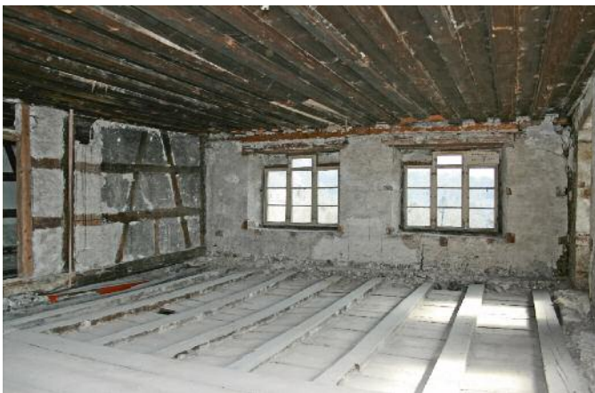
Der grosse Saal im oberen Wohngeschoss mit der Bohlen-Balken-Decke von 1560 und den neugotischen Fenstern aus der Schulhauszeit.
