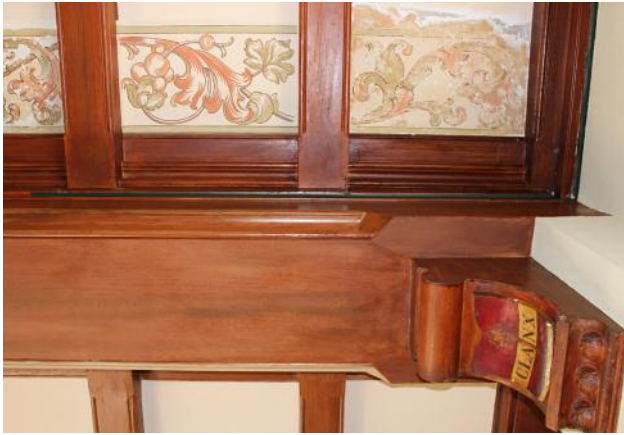
Die Decke der Soldatenstube während der Renovation: Beim Entfernen späterer Farbschichten kam die ursprüngliche, florale Deckenmalerei zum Vorschein. Diese wurde freigelegt und wieder hergestellt (Felder links).
