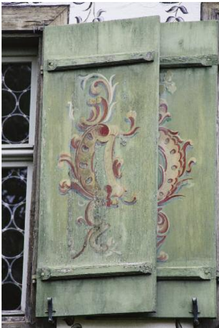
Vierzig Jahre nach der Restaurierung 1972 sind die Schäden an den Malereien deutlich wahrnehmbar. (Foto: Fontana & Fontana AG, Jona)
