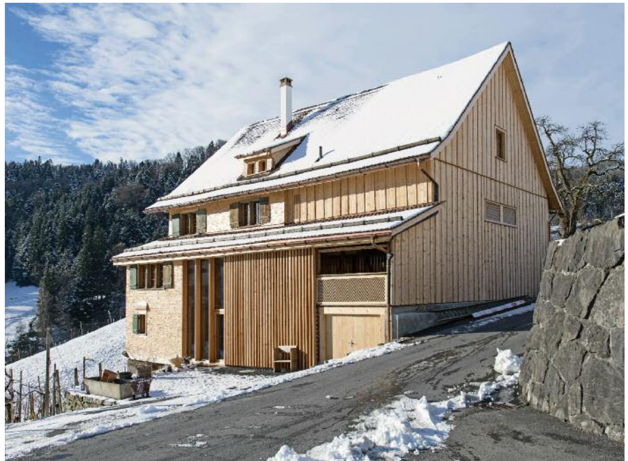
Während die Hauptfront ihr Biedermeierkleid behielt, verraten die spannungsvoll gestalteten Trauffassaden die jüngsten Interventionen am Haus.
