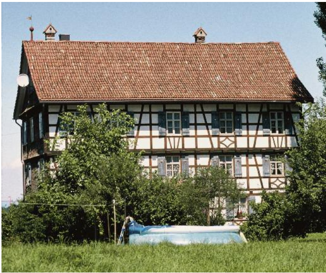
Der Gutshof des «Kleinen Hahnberg» (Berg SG) wies 2000 noch ein arg verwittertes, aber sehr seltenes Dach mit Mönchs- und Nonnenziegeln auf. Bei der Renovation wurden alle noch brauchbaren Ziegel auf die Schau-seite versetzt, so dass in dieser Ansicht das alte Dach wieder intakt ist.
