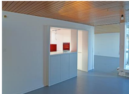
5. Die Renovation des Wohn-/Essbereiches erfolgte gemäss bauzeitlichem Baubeschrieb: Die ursprüngliche Tannenholzdecke, die diesen Bereich gestalterisch auszeichnet, wurde lediglich gereinigt. Anstelle des Teppichs ist der im Baubeschrieb vorgese- hene Linoleum verwendet worden. Einzig die Einbauküche wurde durch ein zeitgemässes Pendant ersetzt, wobei das histo- rische Farb- und Materialkonzept übernommen wurde.
