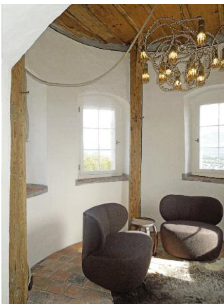
Das Turmzimmer im Ostturm gehört zur Hoch- zeitssuite. Tonplattenboden, Verputz und Holz- decke wurden restauriert, von den diversen Farb- fassungen rund um die Fensterbänke wurde eine graue Variante nachgezogen.
