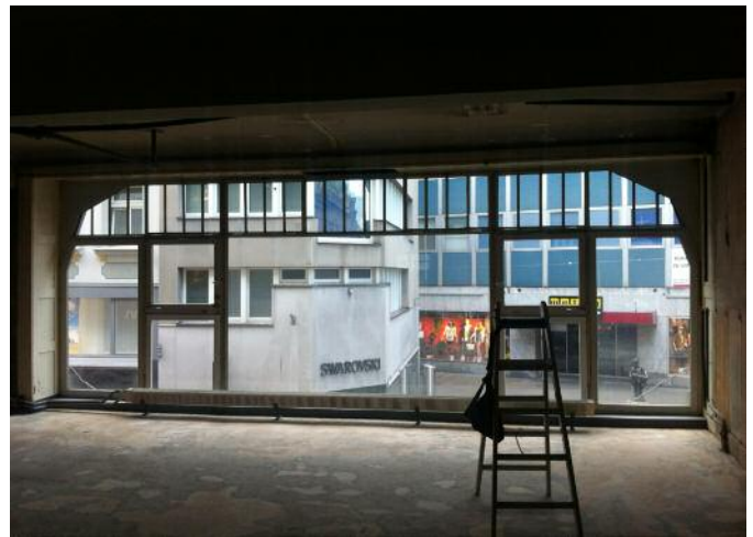
Freie Sicht auf die Multergasse: Die Fensterflächen im ersten Obergeschoss konnten von Transparenten, eingebauten Werbekästen und hervorschauenden Klimageräten befreit werden, so dass nun wieder eine Nutzung mit Tageslicht möglich ist.
