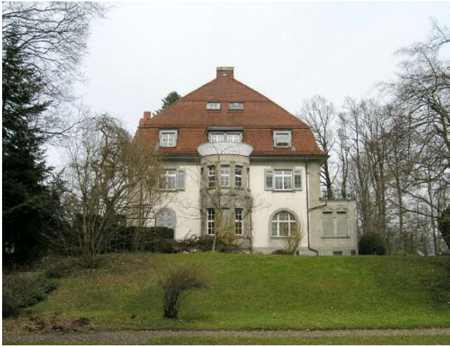
Dank konstantem Fassadenunterhalt mussten nur wenige exponierte Naturstein- und Holzpartien renoviert oder ersetzt werden. Der Fassadenanstrich stützt sich weitgehend auf den Befund ab.
