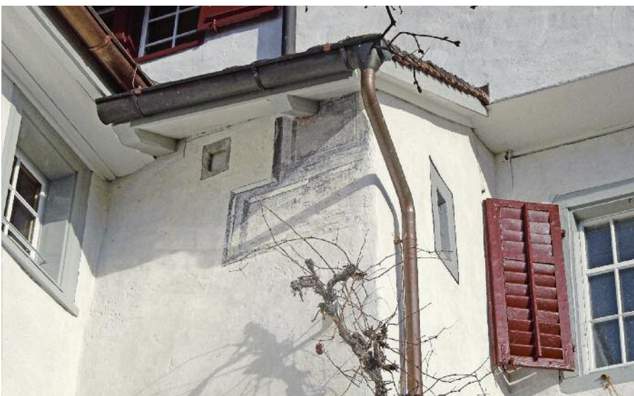
Am Aborterker zwischen Kernbau und Westtrakt wurden zwei Quader einer gemalten Eckquadrierung freigelegt.
