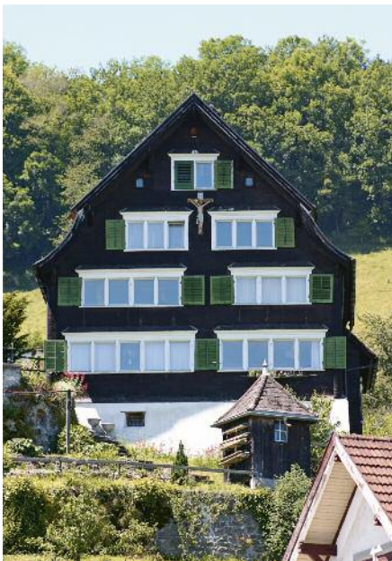
Die Südfassade vor der Renovation.
