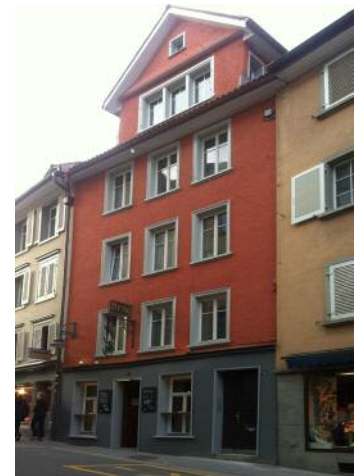
Fassadenansicht mit kürzlich umgebautem Restaurant Krug im Erdgeschoss. Die Deckenmalerei befindet sich im vierten Obergeschoss.
