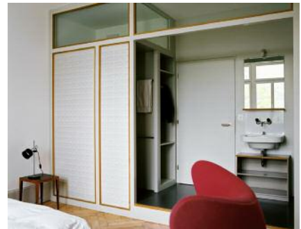
Grosszügiges Hotelzimmer mit sorgfältig integrierter Nasszelle. Die Wasserleitungen befinden sich im neu eingebauten «Sockel», wodurch die originale Raumstruktur möglichst wenig verändert wurde.
