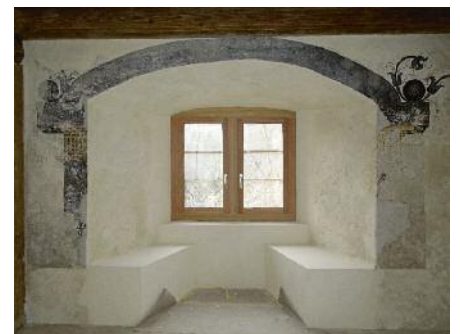
Dieselbe Fensternische (vgl. Abb. links) nach der Reinigung und Konservierung der Malerei. Ergänzt und retuschiert wurde im Wesentlichen der Fensterbogen, die Fragmente werden dadurch zusammengebunden und die Nische erhält mehr Kraft.
