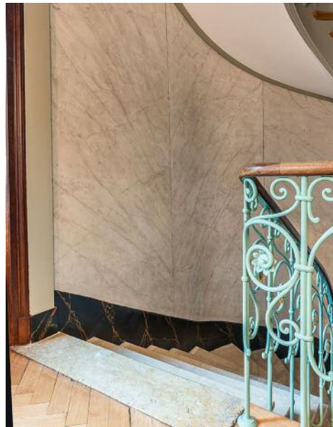
Befunde an den Wänden im Treppenhaus zeigten unterschiedliche Imitationsmalereien. Die Besitzer entschieden sich für die Restaurierung dieser Marmorierungen.
