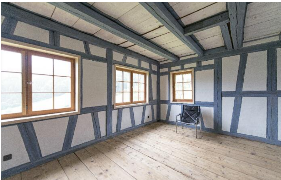
Das 1730 aufgesetzte dritte Geschoss wird von der blaugrau gefassten Fachwerkkonstruktion und den entsprechend gefassten Deckenbalken geprägt.
