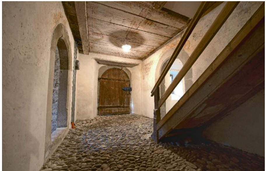
Der Kellergang mit einer barocken Pflasterung und den Malereien über den seitlichen Portalen und an der Decke.
