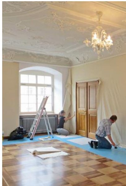
Das Aufbringen der neuen Stoff-Tapete erforderte Geschicklichkeit und Know-how, das heute nicht mehr alle Tage gebraucht wird.
