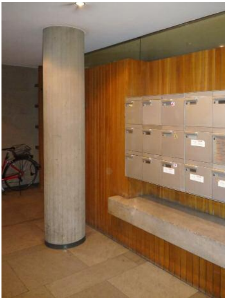
Das Erdgeschoss des Wohn- und Bürohauses war noch im Originalzustand: mit Natursteinplatten, Sichtbeton-säulen und hochwertigem Eichenholzausbau.
