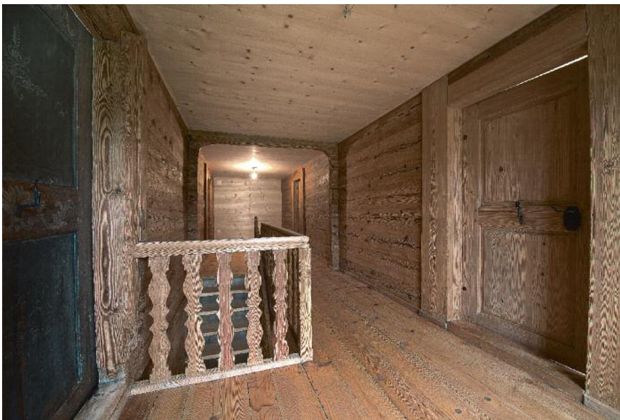
Im Korridor im 1. Obergeschoss mit den schönen Strickwänden wird die Tiefe des Hauses spürbar.
