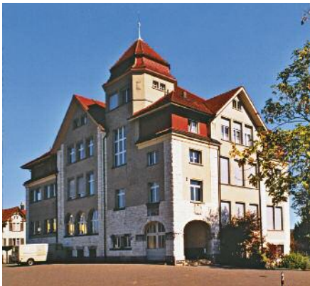
Zustand 2001 mit den Dachgiebeln und -aufbauten der 1960er Jahre und dem zu dunkeln Fassadenputz. (Foto: Daniel Studer, St.Gallen)
