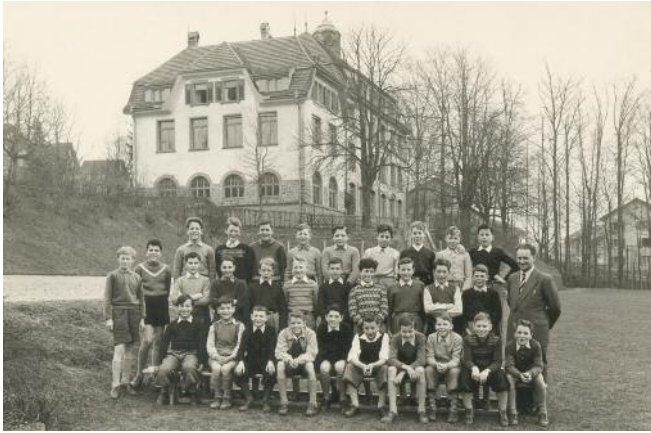
Auf diesem Klassenbild aus den 1950er Jahren ist der ursprüngliche Verlauf des Terrains noch gut erkennbar. Die Gebäudehülle hat sich über mehr als hundert Jahre in einem nahezu unveränderten Zustand erhalten; hier waren nur Unterhaltsarbeiten zu erledigen.
