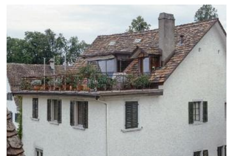
Das Haus am Endingerplatz in Rapperswil hatte bereits eine «Zinne» aus dem 19. Jahrhundert. Als 2000–2002 das Dach ausgebaut wurde, verstand es Architekt Felix Inglin die Dachaufbauten so zurückhaltend und feingliedrig zu gestalten, dass sie die Dachlandschaft nicht beeinträchtigen.
