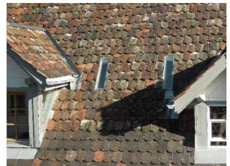
Wenn keine Belüftung, sondern nur Licht gefragt ist, wirken diese von Paul Rutz entwickelten Schlitzfenster wahre Wunder. Der ziegelbündige Einbau ohne Einfassung bewirkt, dass sie weitgehend in der Dachhaut verschwinden (Lichtensteig, Löwengasse).
