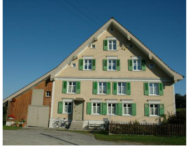
An der Fassade lässt sich die Baugeschichte ablesen: Die drei mittleren Fensterachsen des Erdgeschosses zeichnen mit den zwei darüberliegenden den Kernbau von 1473 ab, die äusseren Achsen und die Geschosse ob dem Gesimse stammen aus dem 18., die Fassadengestaltung aus dem 19. Jh.
