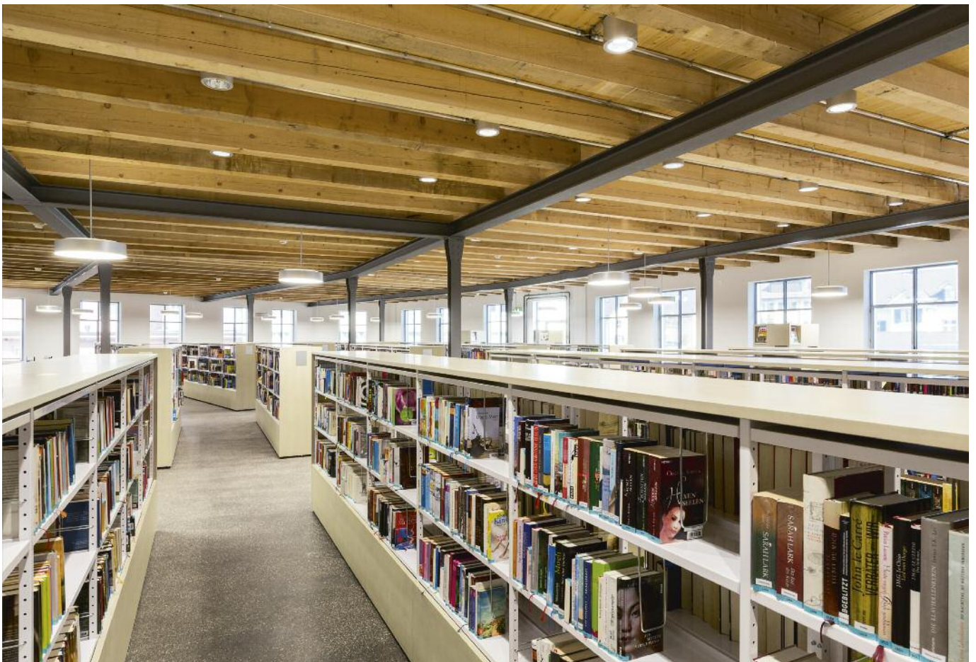
Die Stadtbibliothek im sorgfältig renovierten Ostflügel. Die Position der Bücherregale ist von der 80-jährigen Statik bestimmt worden.
