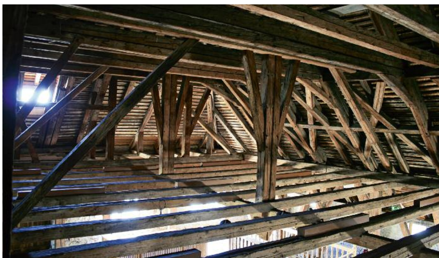
Das Schloss Werdenberg erhielt nach dem Brand von 1695 einen neuen Dachstuhl. Der Blick in die zweite Ebene des Daches zeigt die Hängesäulen, an denen die untere Kehlbalenlage aufgehängt ist. Dadurch ergibt sich im ersten Dachgeschoss ein weitgehend stützenfreier Lagerraum.
