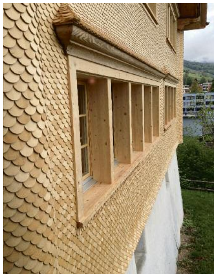
Das neue Schindelkleid steht dem alten Pfarrhaus hervorragend. Entsprechend dem Vorzustand wurden die Ecken rund «eingepackt» und über den Fenstern Abwurfdächli angebracht.
