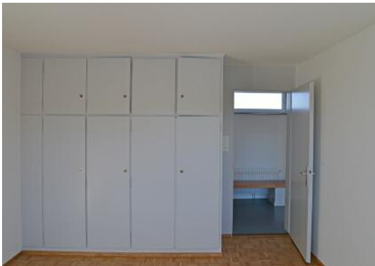
4. Im Rahmen der Renovation wurde der Teppichboden in den Schlafzimmern entfernt und der darunter liegende, bauzeitliche Klebeparkett wieder instand gesetzt. Am gesamten historischen Raumprogramm sowie an praktischen Einbauten wie Wandschrän- ken wurde festgehalten. Ebenso sind Türen und Türgewände noch im Original erhalten. (Bilder 4-6: Renovierte Wohneinheit, Biser- hofstr. 50)
