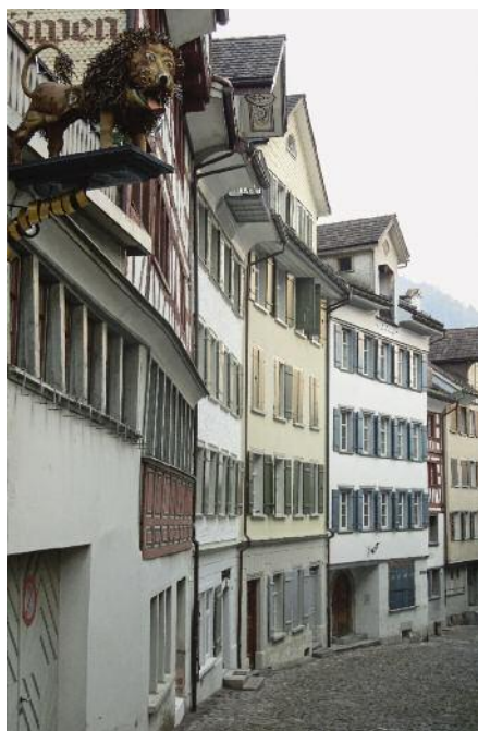
Die Löwengasse in Lichtensteig wird stark von den Aufzugserkern bestimmt, die immer wieder eine kurze Unterbrechung der Traufe bedingen. Sie sind eine willkommene Gelegenheit, Licht in die Dachräume zu bringen.
