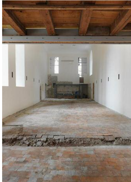
Der mittelalterliche Tonplattenboden wurde mit einem neuen Bodenbelag versehen. Im Vordergrund ist die ehemalige Chorstufe sichtbar.
