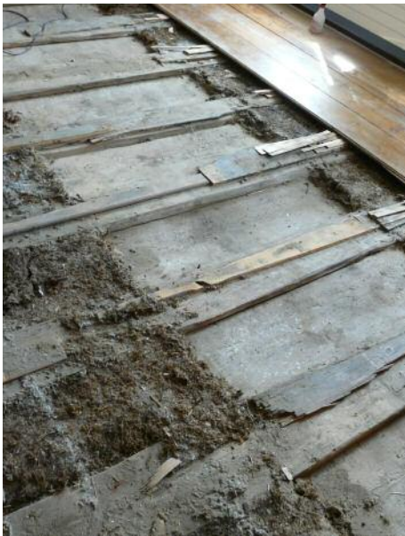
Über dem Wohnzimmer im Erdgeschoss fand man eine gotische Holzplattendecke, die ohne Nägel, nur durch geschickte Verkeilung mit den Balken angebracht ist.
