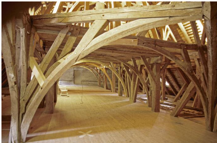
Der Dachstuhl, der die drei alten Flügel der Konventsbauten des Klosters Marienberg in Rorschach überspannt, wurde kurz nach 1500 in berauschender Eleganz errichtet. Die Auswechslung einzelner schadhafter Hölzer ist an deren heller Farbe ersichtlich.
