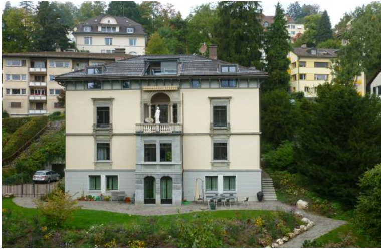
Das Haus am Magniberg 10 erinnert mit seiner strengen Axialsymmetrie und dem Renaissance-Dekor an eine von Palladios Villen. Wichtige Fassadenelemente sind die Sandstein-Fensterrahmen, die Loggia mit Serliana und Steinbalustrade und die Geschossgesimse.
