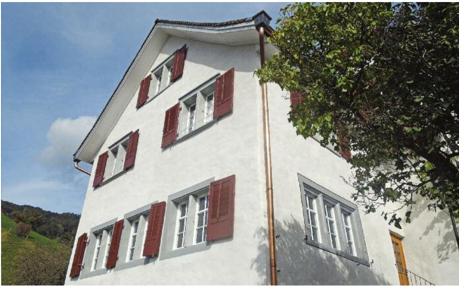
Der frisch mit Sumpfkalk verputzte Westtrakt. Die Fenstereinfassungen der Westseite wurden teilweise in Rorschacher Sandstein ersetzt, das gotische Drillingsfenster hingegen sorgfältig restauriert.
