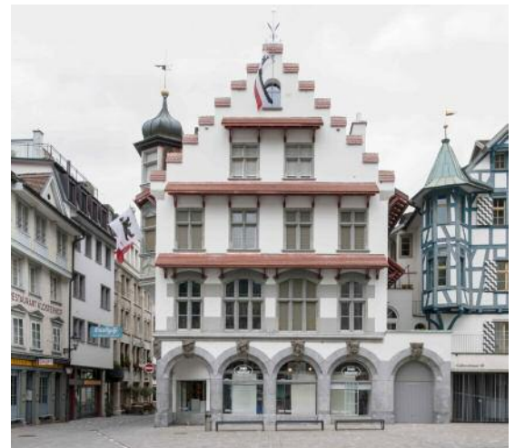
Die renovierte Fassade 2012 mit dem rekonstruierten Treppengiebel und den Klebdächern.
