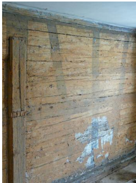
Im ersten Stock sind die ehemaligen Aussenwände des Kernbaus ersichtlich. Sie sind in Strickbauweise ausgeführt und mit einer Riegelmalerei geschmückt.
