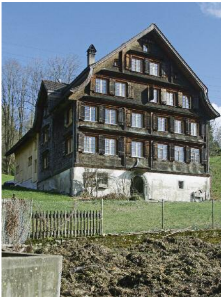
Dank Innenisolation behielten die Fassaden des Wohnhauses ihr von der Sonne braun gebranntes Schindelkleid. (Foto: Kant. Denkmalpflege)
