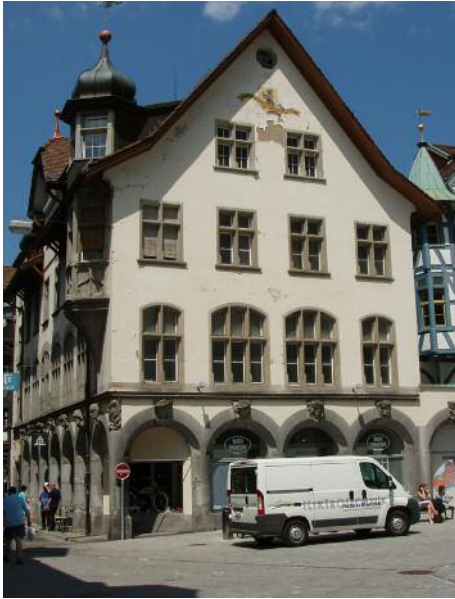
Bei einer Aussenrenovation 1930 wurde statt des Treppengiebels ein weiter, giebelseitiger Dachüberstand geschaffen. Zustand vor der Renovation 2011.
