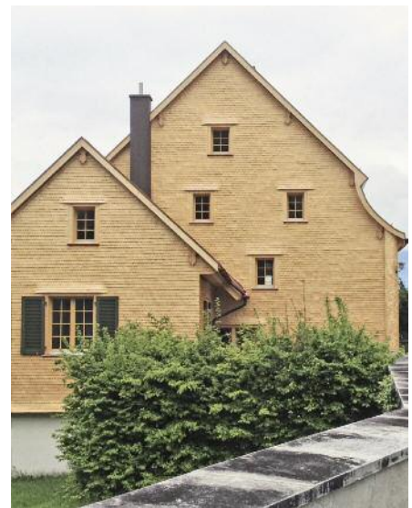
Das neue Schindelkleid steht dem alten Pfarrhaus hervorragend. Entsprechend dem Vorzustand wurden die Ecken rund «eingepackt» und über den Fenstern Abwurfdächli angebracht.
