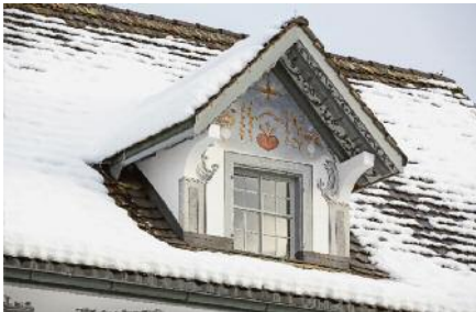
Vierzig Jahre nach der Restaurierung 1972 sind die Schäden an den Malereien deutlich wahrnehmbar. (Foto: Fontana & Fontana AG, Jona)
