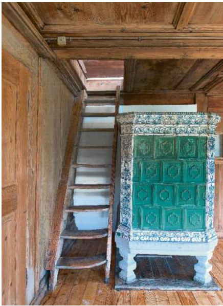
Der Zehnderofen in der Prunkstube und daneben die klassische Ofenstiege in das Schlafgemach. Diese Stiege und ihr Pendant in der kleinen Stube waren ursprünglich die einzigen Verbindungen vom Erdgeschoss ins Obergeschoss.
