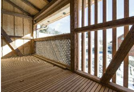
Die Laube wurde durch eine Teilverschalung heller und dadurch besser nutzbar.
