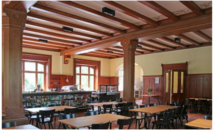
Blick in die neu eingerichtete Soldatenstube mit rekonstruierter Deckenmalerei. Die Wandtäferungen mussten lediglich aufgefrischt werden. Bei den Pfeilern und den Deckenbalken handelt es sich um maserierte Betonpfeiler/-balken, d.h. Holzimitate.
