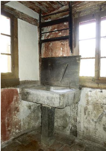
Der Schüttstein in der alten Küche entwässert direkt über die Fassade, darüber eine kleine Tellerkräze.
