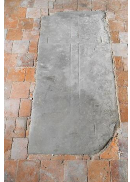
Die erhaltenen Stiftergräber im äusseren Chor wurden an Ort belassen und fachgerecht zugedeckt.
