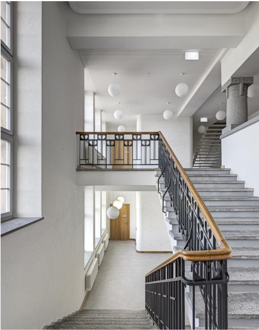
Die Treppenanlage war weitgehend im Originalzustand erhalten und besteht durch die Materialisierung, die kunsthandwerkliche Arbeit und die Formensprache, einem strengen, geometrischen Jugendstil.
