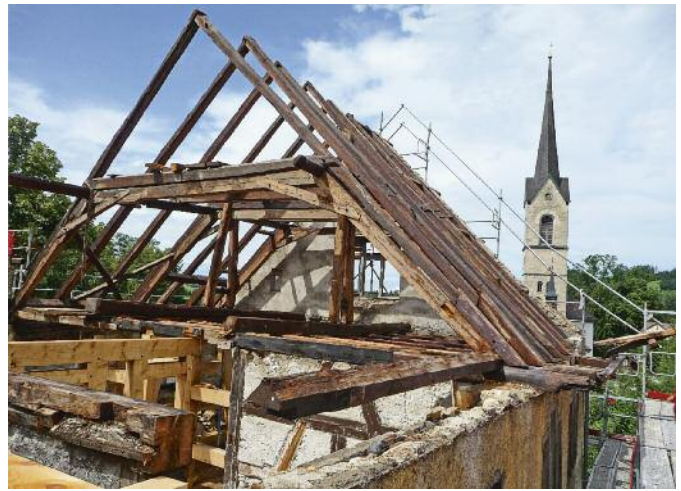
Der Dachstuhl wurde Holz für Holz vollständig abgebaut, wo nötig ergänzt und wieder in klassischer Zimmermannstechnik aufgerichtet.
