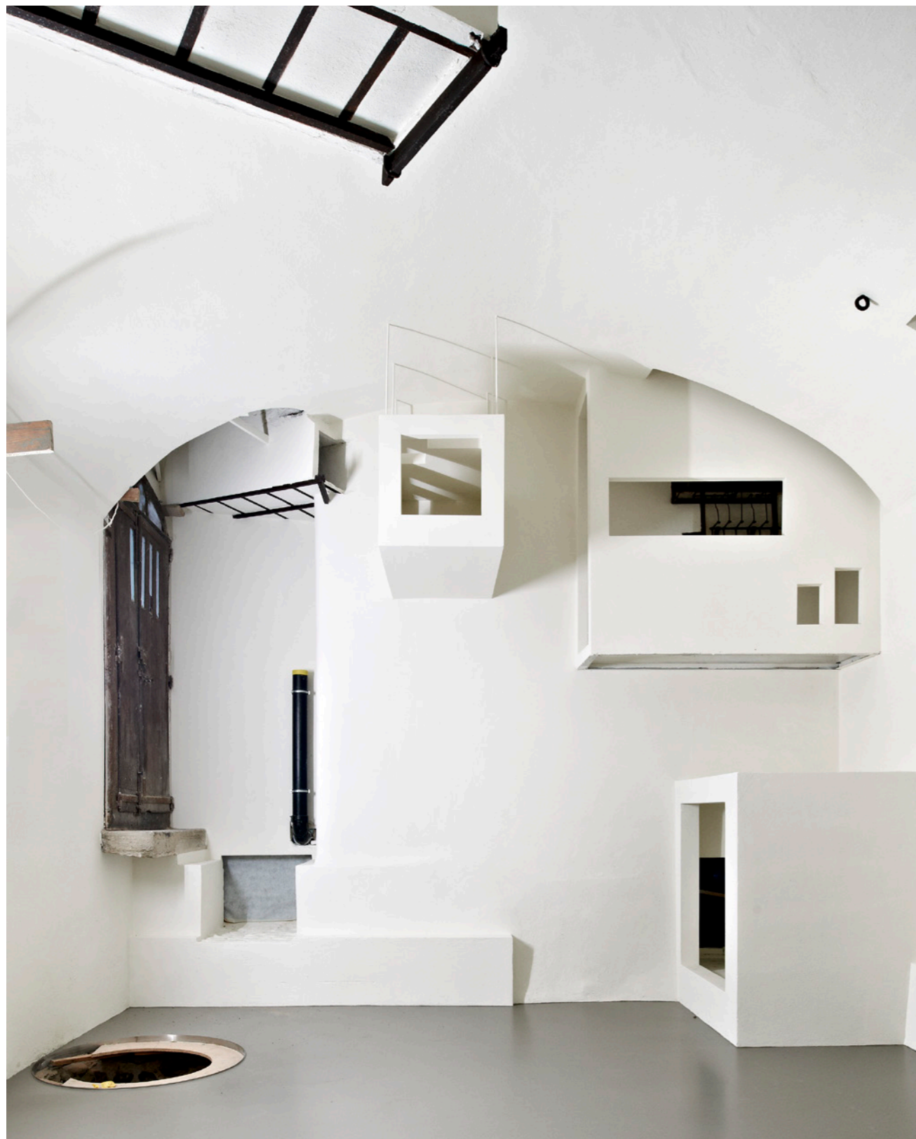
Château de l'Aile, Vevey: la chaufferie historique de 1840, dépouillée de ses équipements techniques récents, lors de la rénovation des années 2010.
