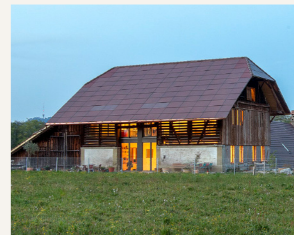
L'ancienne grange-écurie du Weyergut avec sa toiture solaire, devenue l'emblème de la réhabilitation douce du site.
