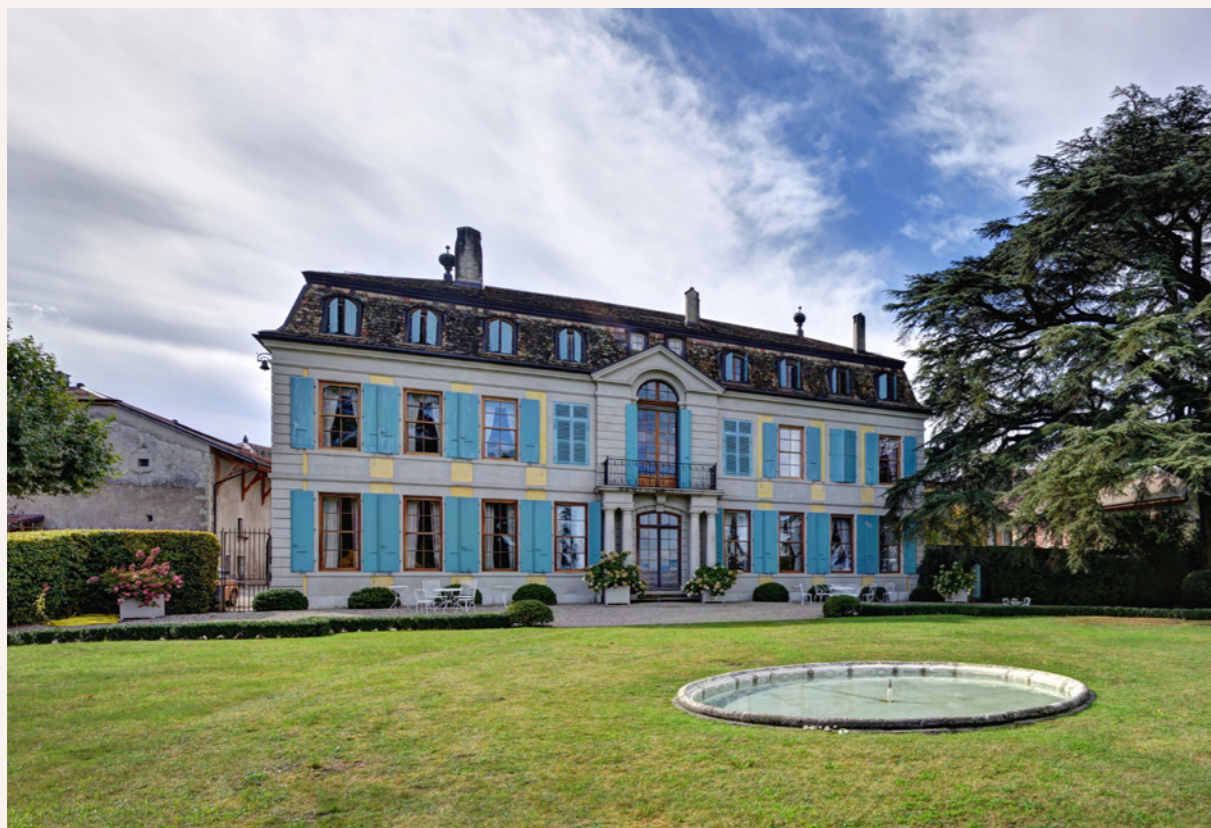
Domaine Micheli, façade principale de la maison de maître. En arrière-plan, le rural accueillant les nouvelles installations de production de chaleur.
