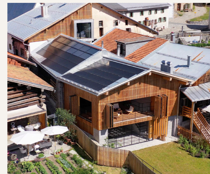
La «centrale solaire» de San Niclo 9, couvrant l'ensemble des besoins énergétiques du bâtiment rénové.
