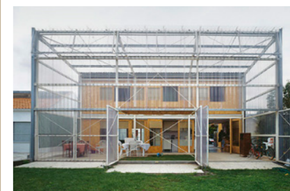
Lacaton & Vassal, maison Latapie, Floirac, 1993. Une des premières «maisons-serres» du couple d'architectes, réalisée pour une famille avec un budget extrêmement restreint. Un volume en bois «définit un espace d'hiver isolé et chauffé, ouvert sur la serre [constituant] un espace habitable de la maison, équipé de larges ouvrants d'aération pour le confort d'été. La mobilité des façades [...] permet à la maison d'évoluer du plus fermé au plus ouvert selon les besoins et les désirs de lumière, de transparence, d'intimité, de protection ou d'aération.»
