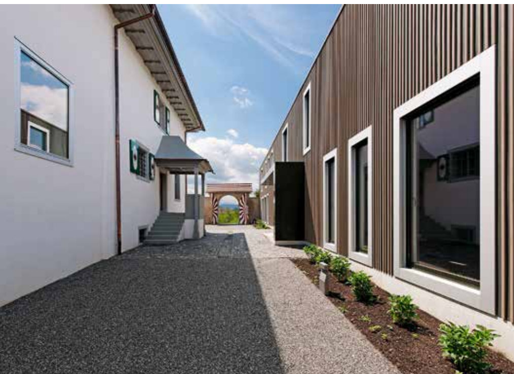
A gauche: faisant corps avec la façade, les grandes ouvertures de l’extension s’offrent modestement à la vue. A droite: semblable à un décor baroque, l’annexe forme le nouvel arrière-plan du château.
