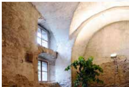
Putzfestigung und Putzrekonstruktion, Haus von Moos, Malans.
