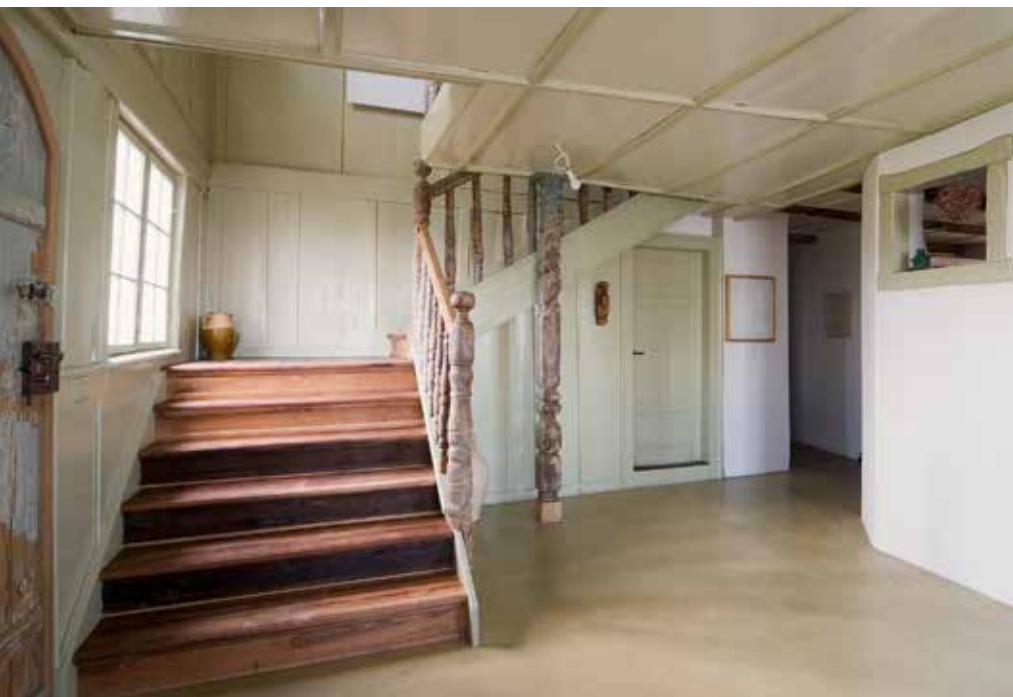
Die Treppenanlage dürfte mehrfach verändert worden sein, wie die verschobene, tragende Säule im Flur vermuten lässt.
