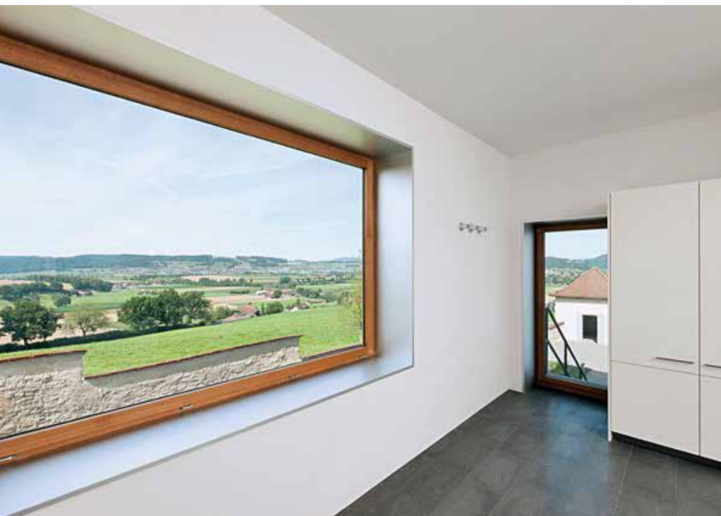
Im neu aufgebauten Anbau ist sämtliche moderne Infrastruktur wie Bäder, Küche, Aufzug und Technik untergebracht.
