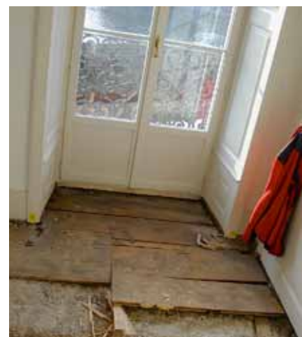
Abb. 4: Entfernen von nicht mehr tragfähigen Blindbodenbrettern
