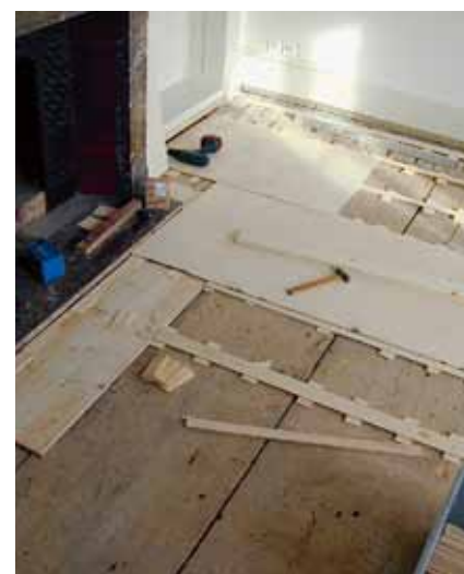
ill. 5: ajustement et encastrement des planches du faux plancher, dont la largeur va jusqu'à 74 cm; préparation des lambourdes réversibles en contreplaqué de bouleau
