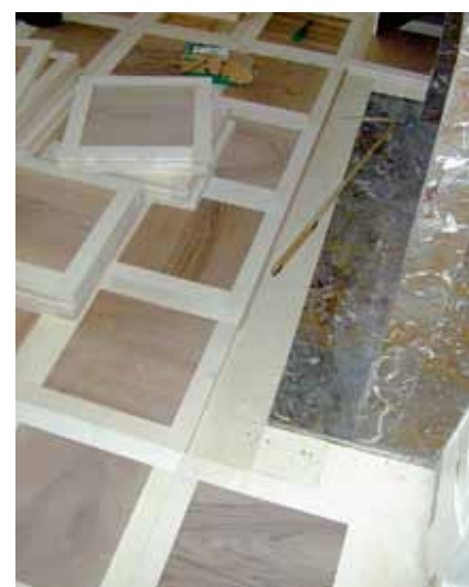
ill. 6: encastrement des nouveaux panneaux de parquet d'une épaisseur de 35 mm
