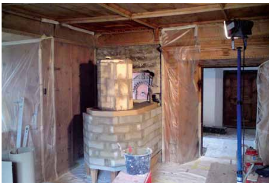
Aufbau des Turmofens im Sprecherhaus in Luzern
