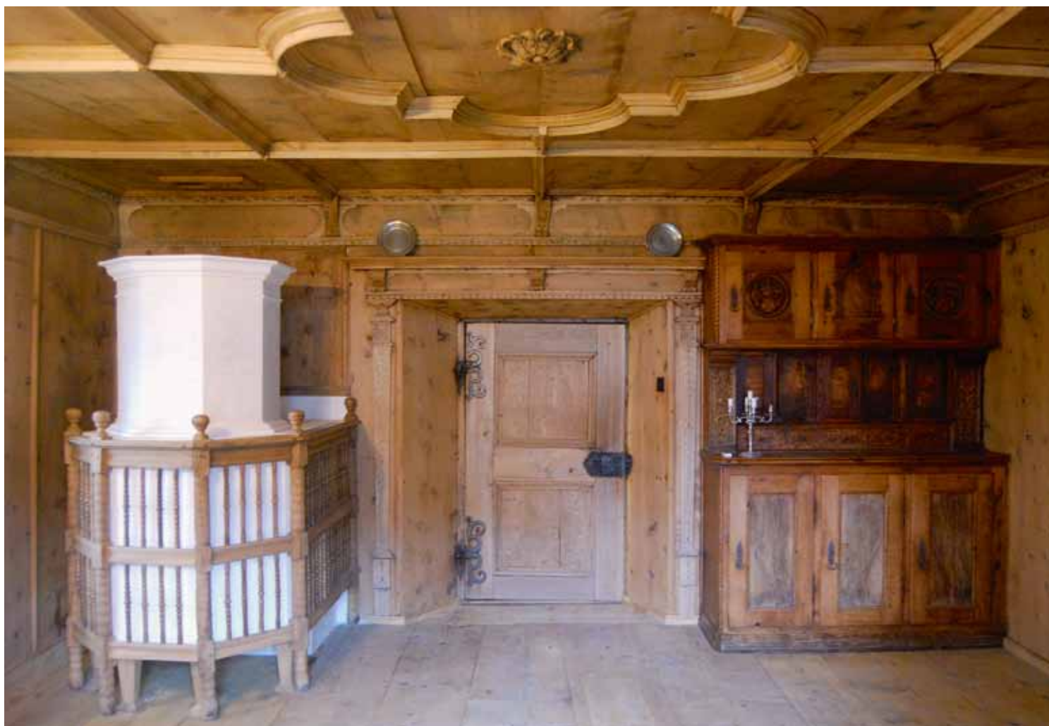
Le poêle à l'achèvement de sa construction. La pièce possède un lambrisage de bois d'arole datant de 1708.
