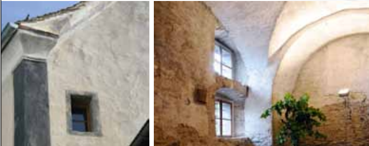
Putzfestigung und Putzrekonstruktion, Haus von Moos, Malans.
