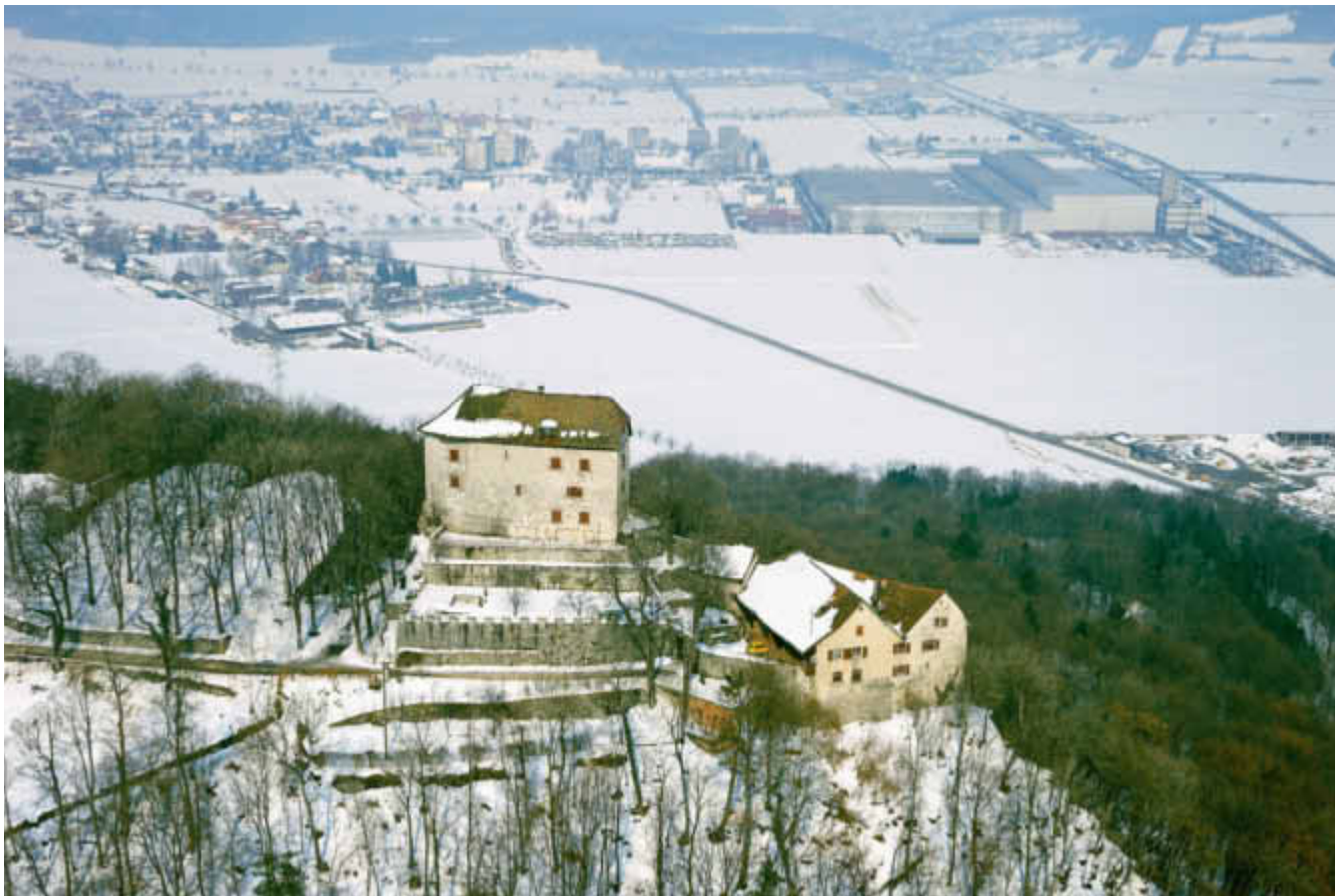
Am östlichen Ende des Kestenberges, erhebt sich das Schloss Brunegg. Darunter befindet sich das Pächterhaus mit seinem besonderen, zweiteiligen Giebel. (Bild vor der Sanierung)
