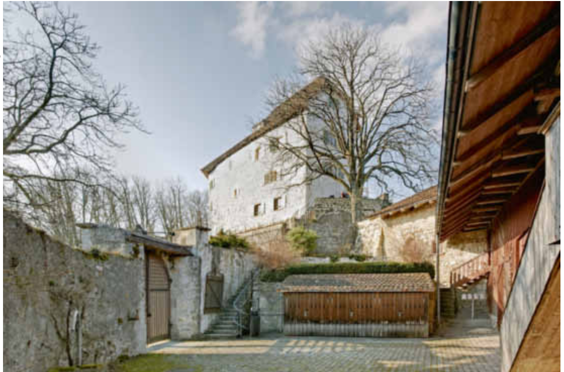
Die Aussensanierung des Mauerwerks ist weitgehend abgeschlossen.
