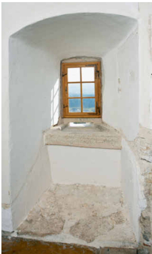
Les niches des fenêtres révèlent la résistance impressionnante des murs du château qui compte jusqu'à quatre mètres d'épaisseur.
