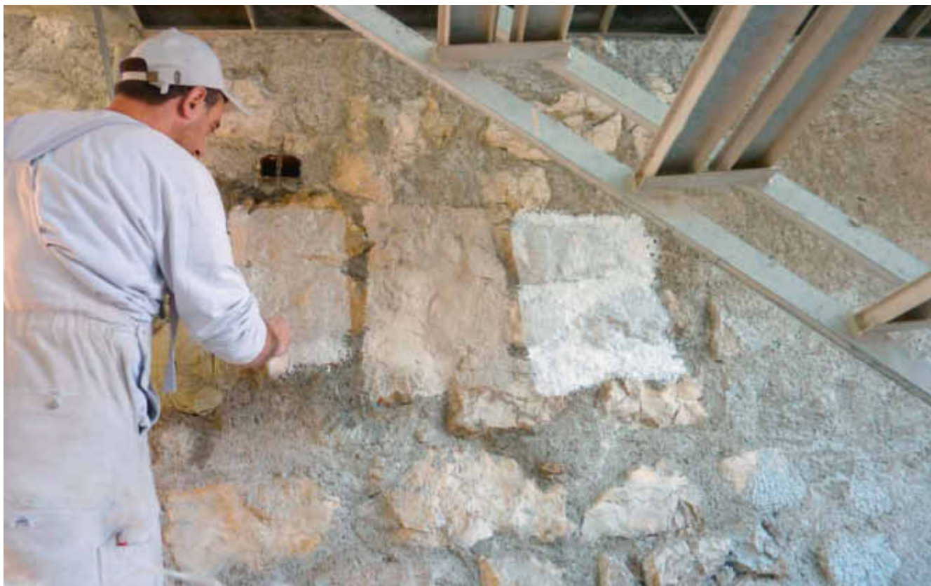
Les experts ont testé toutes sortes de badigeons sur les murs.
