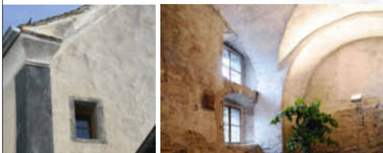
Putzfestigung und Putzrekonstruktion, Haus von Moos, Malans.
