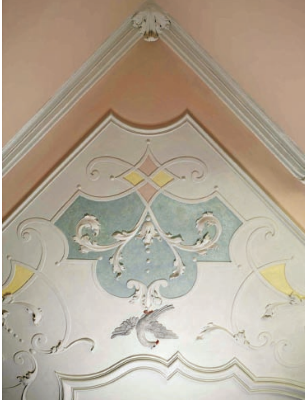
Detail einer Stuckatur in einer der renovierten Wohnungen
