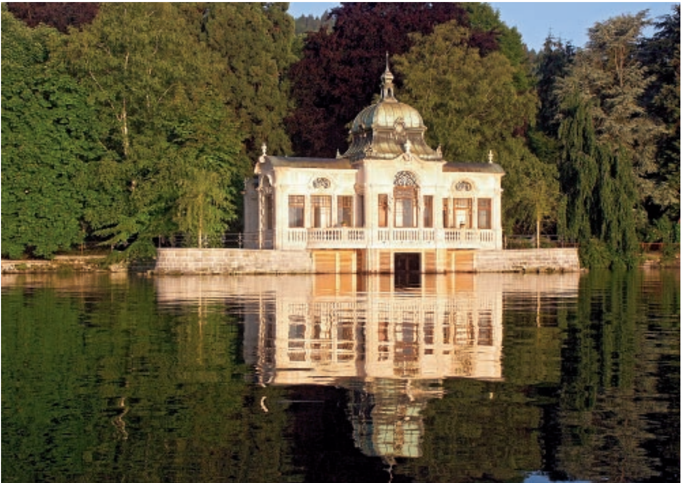
Das Badehaus nach der Renovation, im Abendlicht
