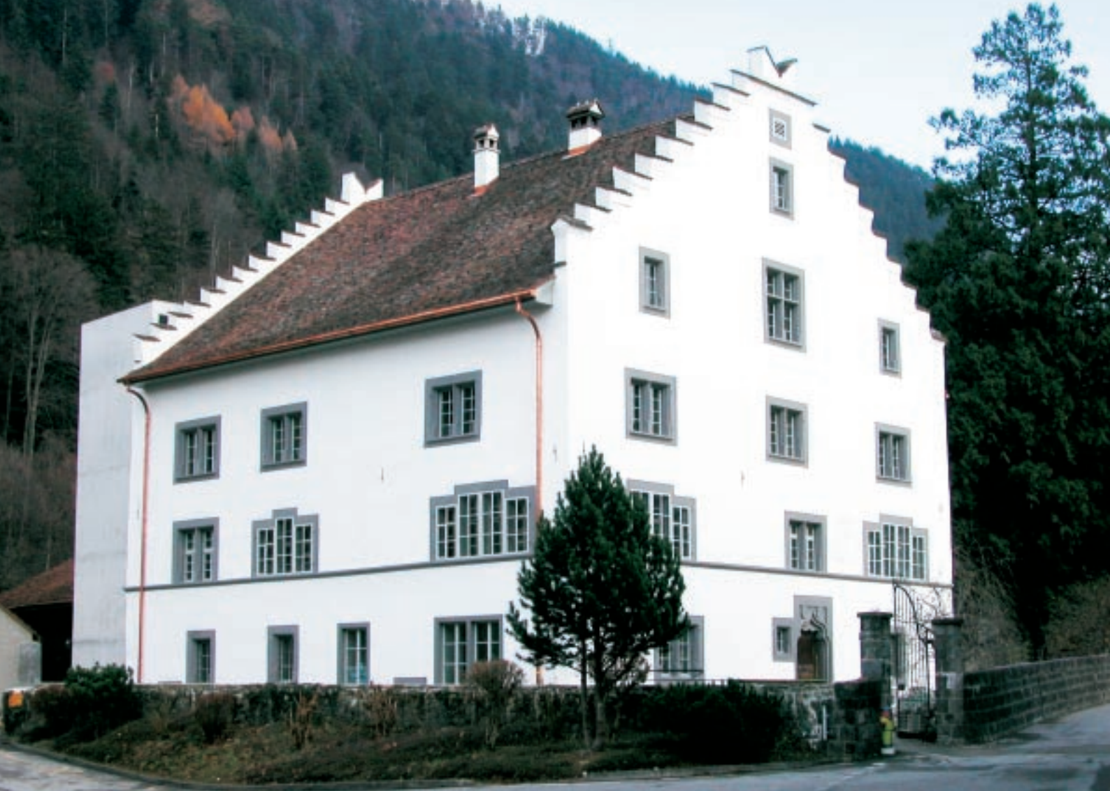
Das Haus «Suworow» nach der Renovation, am linken Bildrand der neu erstellte Treppen- und Liftturm
