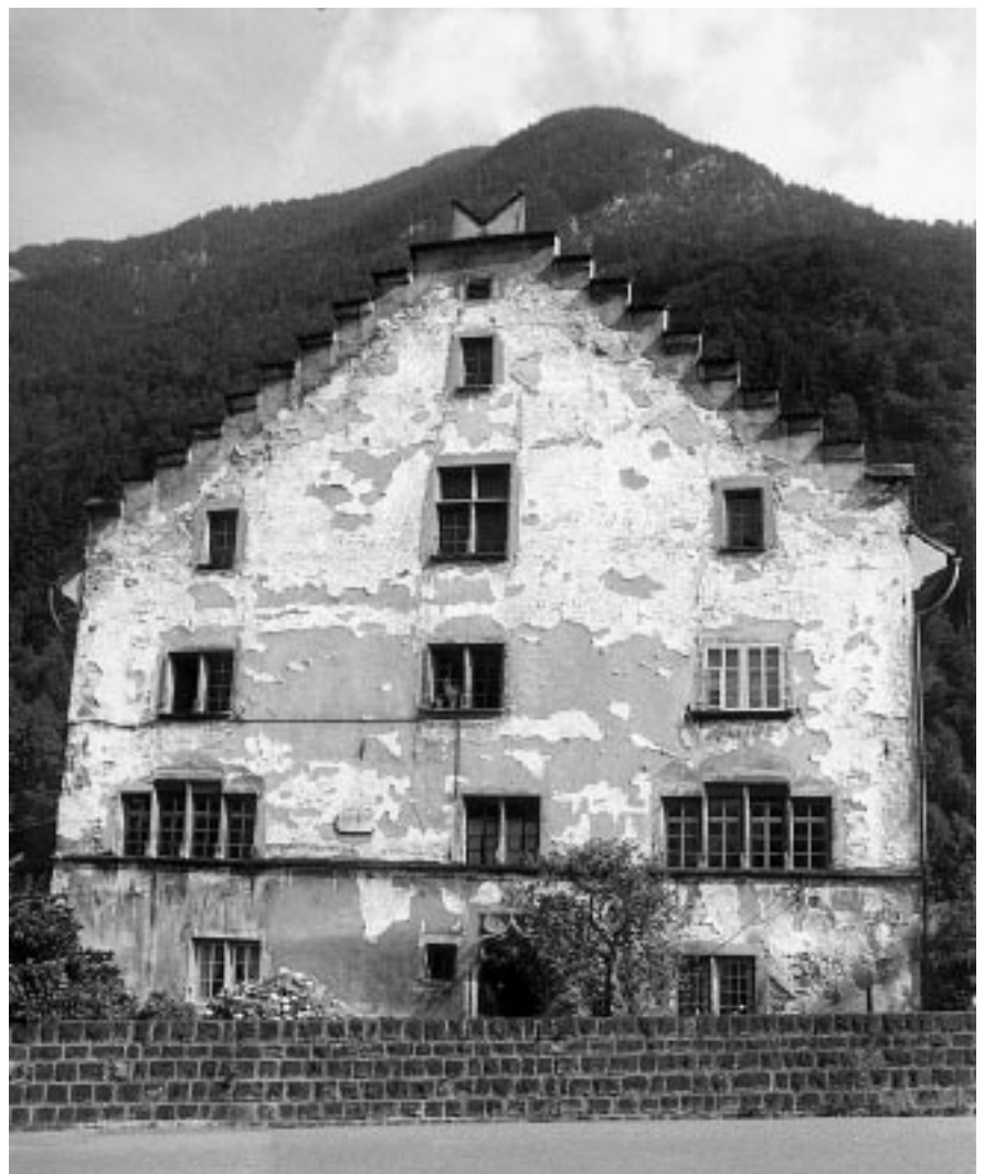
Das Haus «Suworow» vor der Renovation
