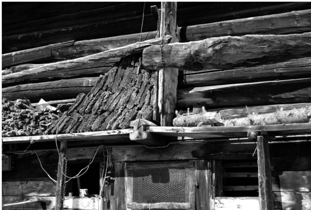
Abb. 24: Stallscheune in Avers-Campsut mit geschoss-spezifischer Strickbauweise. An den zugehauenen Rundhölzern des Heustalls ist die Rundung des Baumstammes noch ersichtlich.
