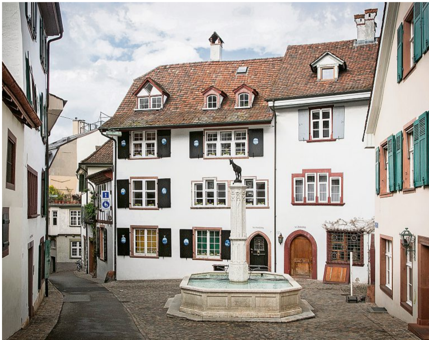
Die beengte Lage am Gemsberg 7 stellt die Industriellen Werke Basel vor eine Herausforderung.
