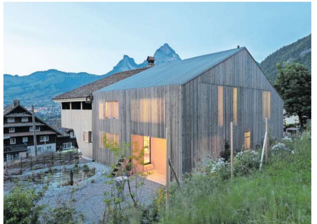
Die ursprüngliche Bausubstanz des Hauses wurde so weit wie möglich gerettet. Der moderne Anbau wurde aus Holz erstellt, das in den umliegenden Wäldern geschlagen wurde.
