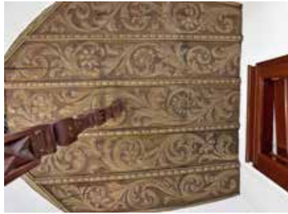
Links: Rest der barocken Stuckdecke, erhalten oberhalb der heutigen Decke im rückseitigen Erdgeschosszimmer. Als Putzträger dienen Bretter, die zur besseren Haftung aufgebeilt und mit handgeschmiedeten Nägeln unter die Deckenbalken genagelt wurden.
