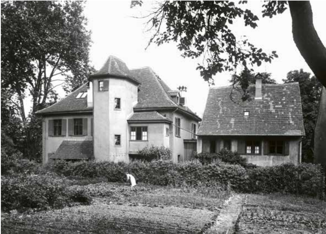
Die Rückseite des Herrenhauses mit Treppenturm vom Vorgängerbau, links davon die Laube über dem Kellerabgang (heute Wintergarten) und rechts der Abtritt im Obergeschoss. Deutlich kleiner das Pächterhaus rechts und davor der Gemüsegarten, an dessen Stelle heute die Dittingerstrasse verläuft. Foto um 1910.
