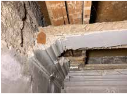
Links: Rest der barocken Stuckdecke, erhalten oberhalb der heutigen Decke im rückseitigen Erdgeschosszimmer. Als Putzträger dienen Bretter, die zur besseren Haftung aufgebeilt und mit handgeschmiedeten Nägeln unter die Deckenbalken genagelt wurden.
