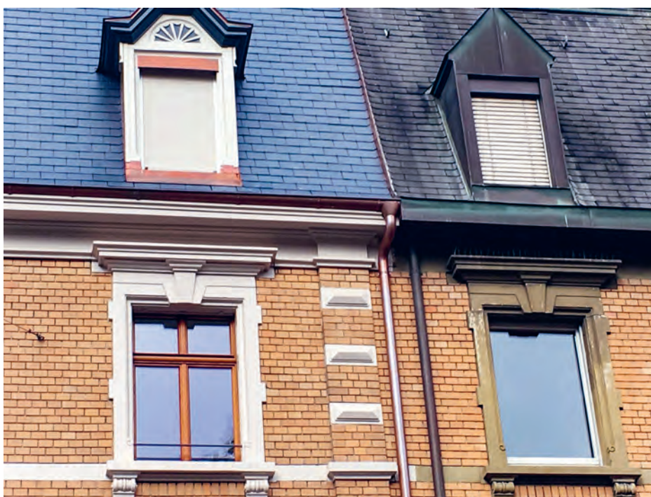
Fenstervergleich: Links das neu eingebaute Eichenholzfenster mit der Originaleinteilung, rechts das Fenster von 1979. Solche auf den ersten Blick unerheblichen Unterschiede prägen in der Summe das Erscheinungsbild eines Hauses wesentlich mit – im Guten wie im Schlechten.
