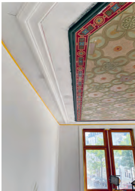
Nachdem der Vorbesitzer das Gebäude beinahe «kaputt saniert» hatte, konnten im Innern schöne Elemente wiederhergestellt werden. Die typische Stuckatur der Decke wurde von einer Spezialfirma angebracht; die farbige Reliefdruckdecke wurde glücklicherweise nicht zerstört, heute erstrahlt sie in neuem Glanz.
