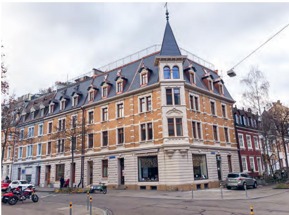
Diese Liegenschaft aus dem Jahr 1898, Ecke St. Johannis-Ring/Mittlere Strasse (Schutzzone, Nähe Augenspital), wurde umfassend und sorgfältig saniert. Bei entsprechender Pflege prägt das charakteristische Gebäude das Quartier noch weitere 100 Jahre.
