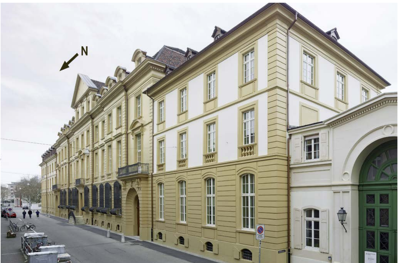
Abb. A3.1: Markgräflerhof in Basel, Westfassade, Eigentümer: Universitätsspital Basel-Stadt (USB), Foto o. D.
