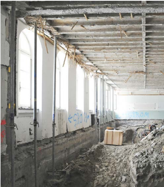
Abb. A1.8 (links) Aushub für die Erdbebenwände im Schulzimmerbereich und (rechts) Schulzimmer mit neuer Erdbebenwand, Aufnahme: 2012 bis 2014.
