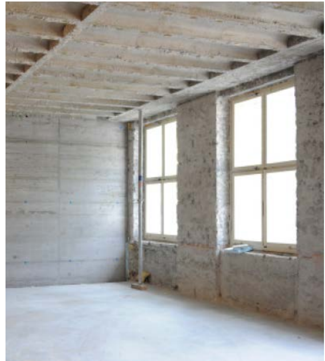
Abb. A1.8 (links) Aushub für die Erdbebenwände im Schulzimmerbereich und (rechts) Schulzimmer mit neuer Erdbebenwand, Aufnahme: 2012 bis 2014.
