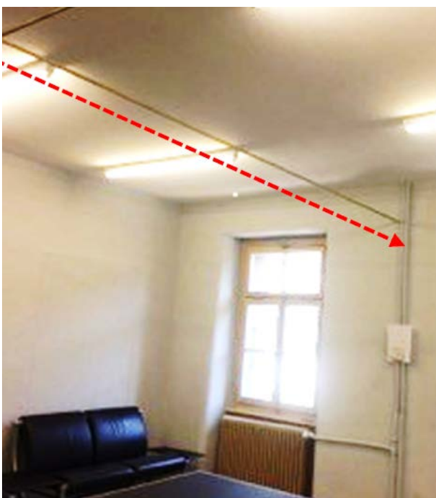
Abb. A2.4 Zugstangen im zweiten Obergeschoss
