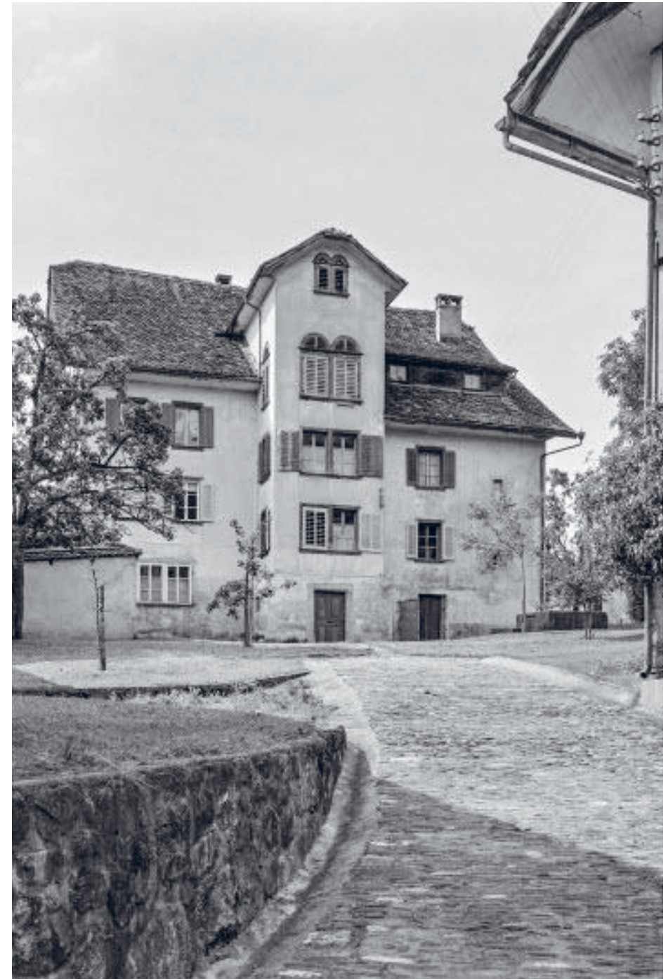
Foto: Mittleres Feldli vor der Restauration Titelbild: Immenfeld
